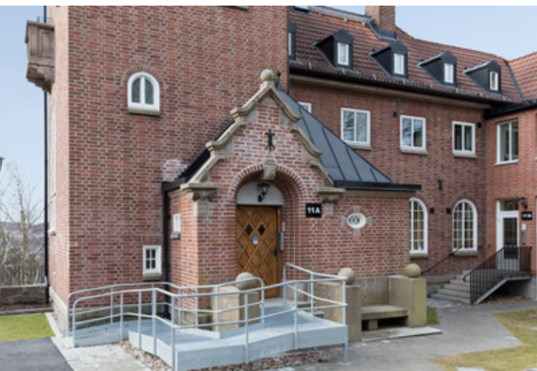
Huset har anpassats för dagens krav på tillgänglighet.
